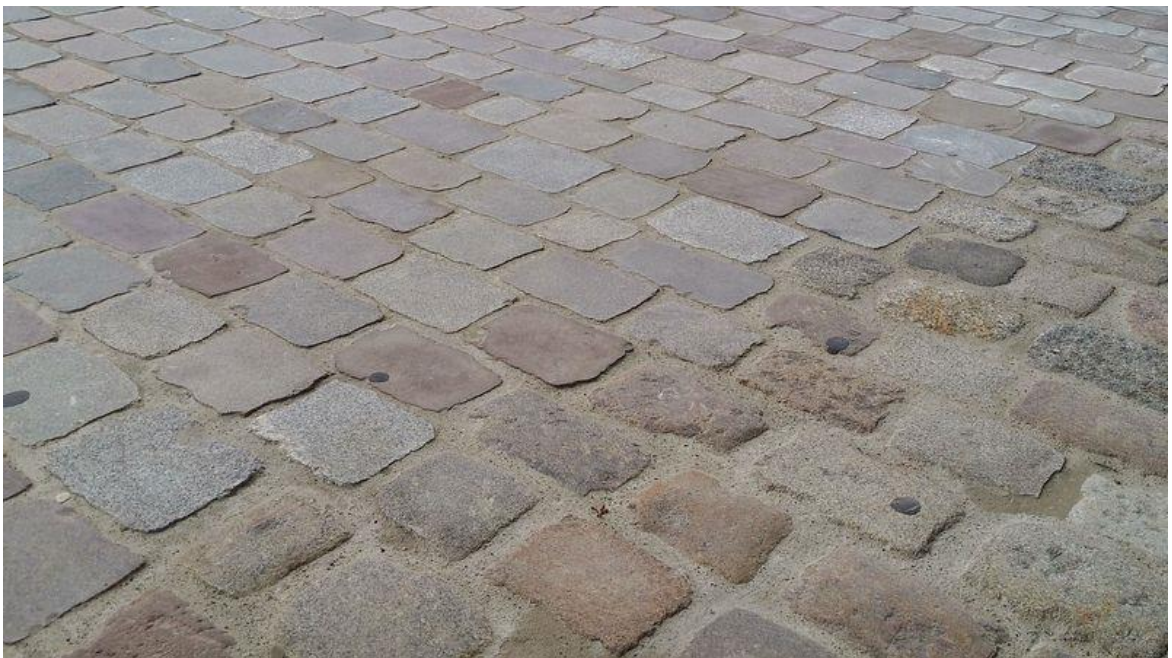
Abbildungen 47 - 49: Beispiele für das Abschleifen von Pflasterbelägen
