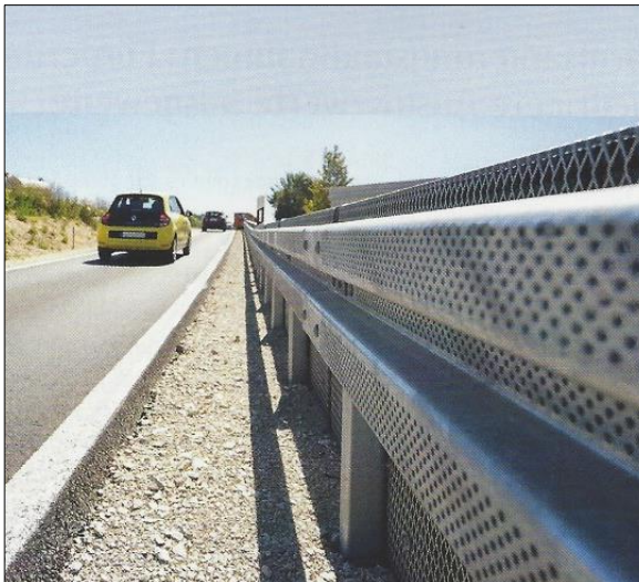
Abbildung 37: Beispiel Lärmschutzplanke (B 33 in Allensbach) Quelle: Straßenverkehrstechnik 9/2020
