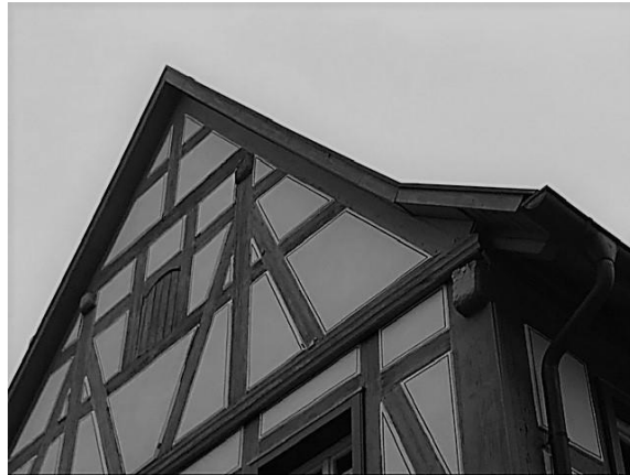
Abbildung 8: Dachvorsprung und Ortgang
