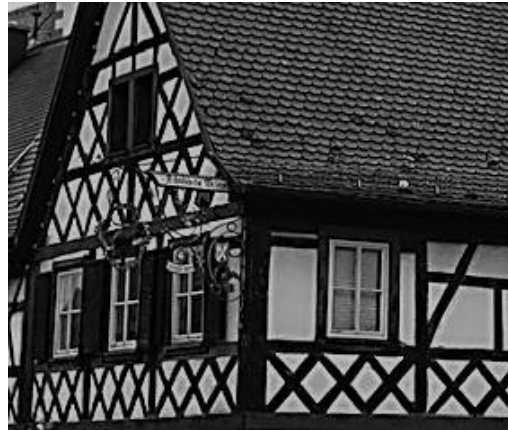
Abbildung 14: Freiliegendes Fachwerk
