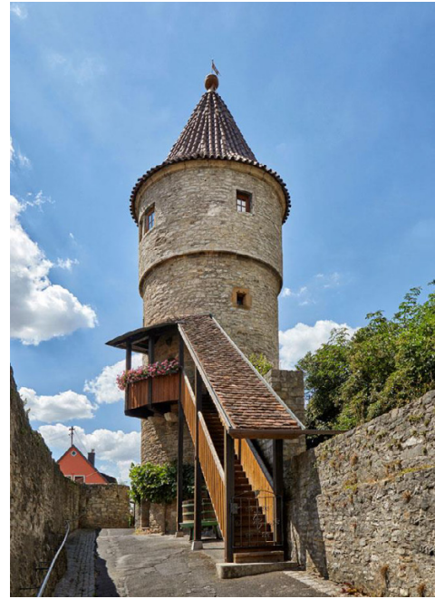
Abbildung 22: Holztreppe, Turm Ortsbefestigung
