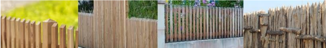
Abbildung 25: Holzzaunvarianten mit senkrechter Lattung
