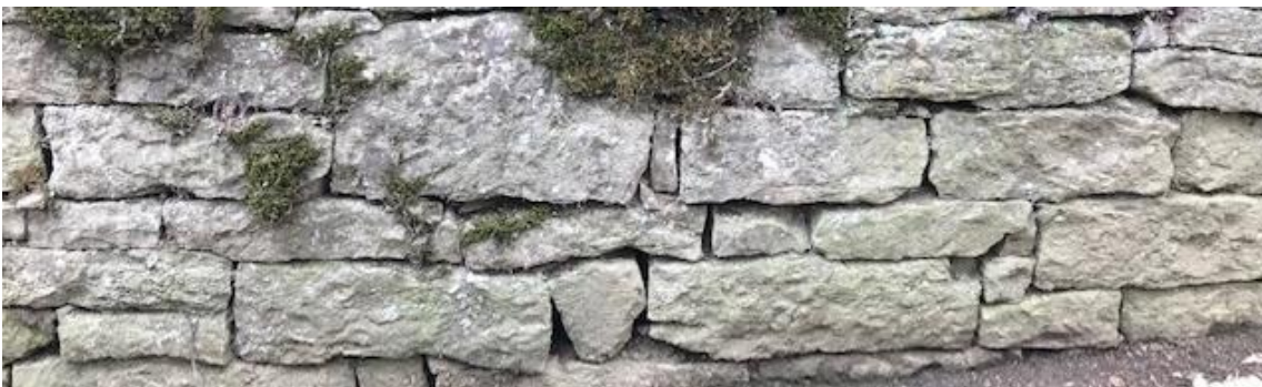
Abbildung 24: Einfriedung aus Muschelkalk
