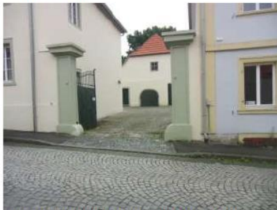
Grundstücksausfahrt mit abgesenktem Bordstein
