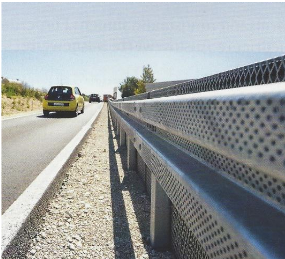
Abbildung 40: Beispiel Lärmschutzplanke (B 33 in Allensbach)
