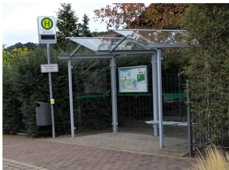
Abbildung 43: Bushaltestelle mit Wetterschutz, Sitzgelegenheit, Informationstafel, stationärer und dynamischer Fahrtzielanzeige und Sprachinformation auf Anforderung (Beispiel Sommerhausen)
