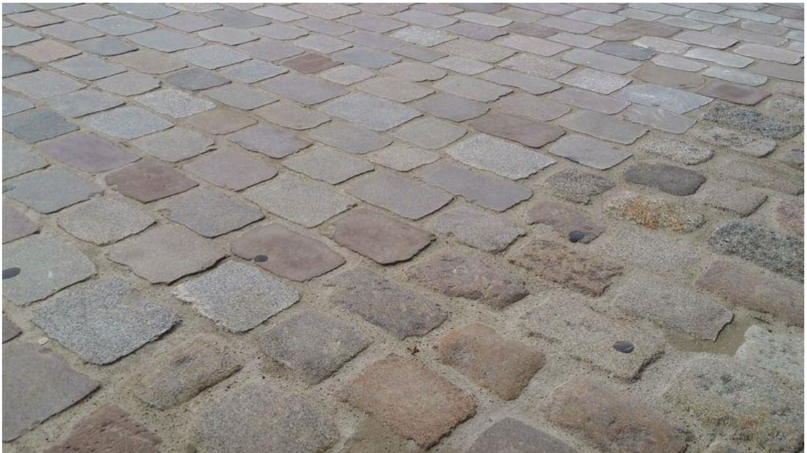
Abbildungen 51 – 53: Beispiele für das Abschleifen von Pflasterbelägen
