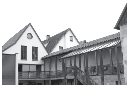
Abb. 2: Beispiel für gelungene Modernisierung mit Balkon und Loggia
