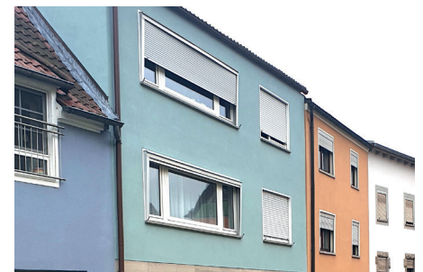
Abb. 3: Beispiel für unharmonische, liegende Fensterformate
